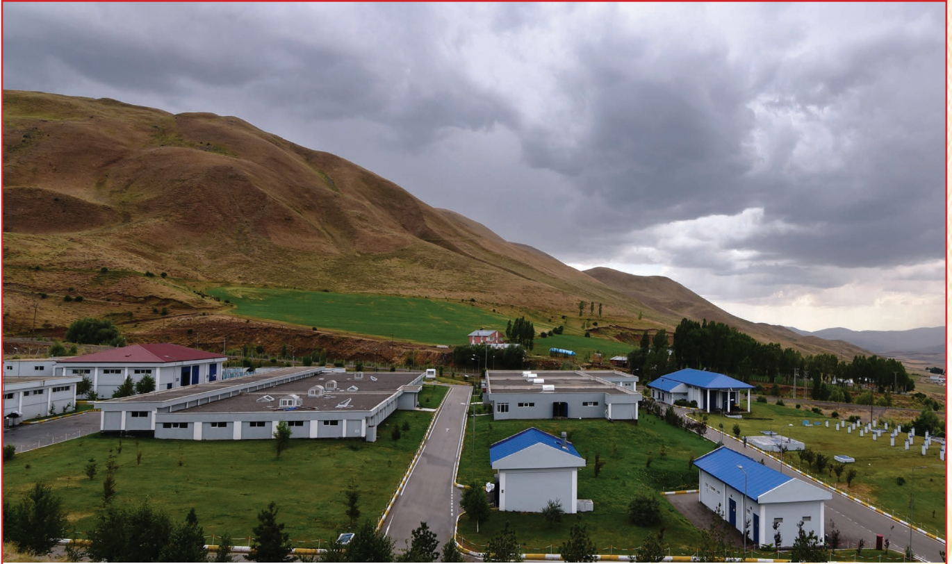
Erzurum İçme Suyu Arıtma Tesis Görünümü
