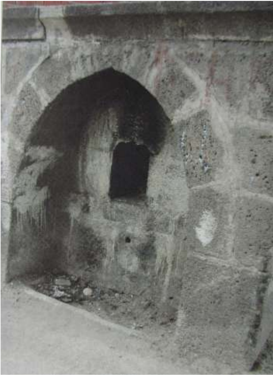
Hacı Cuma Camii Çeşmesi
