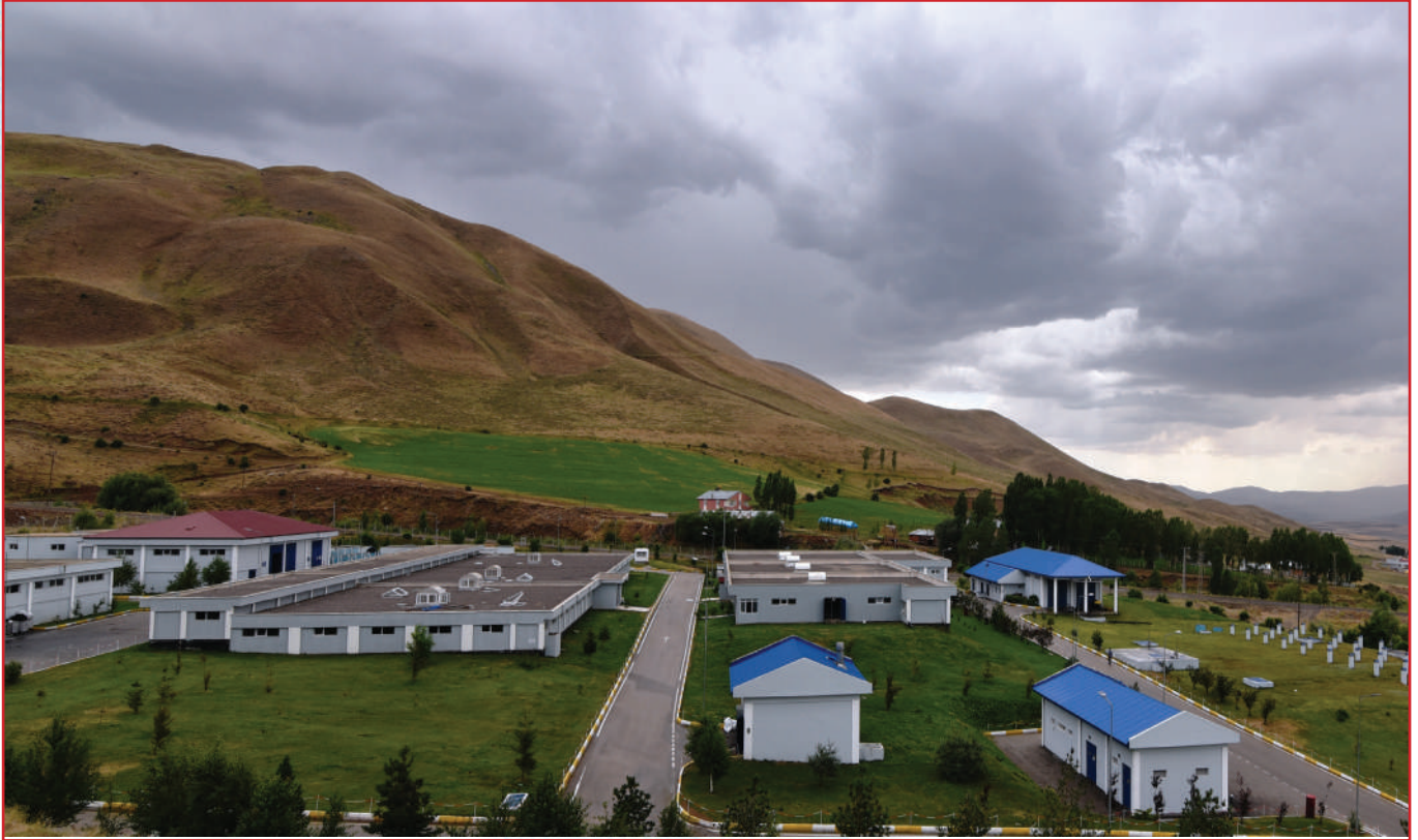
Erzurum İçme Suyu Arıtma Tesisinin Görünümü
