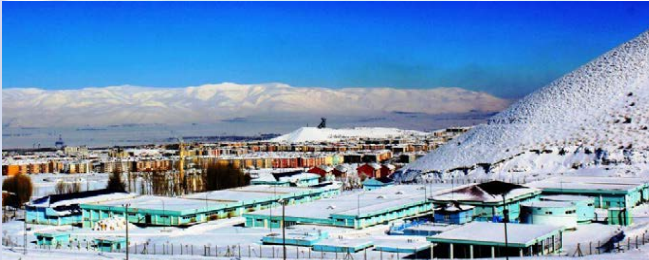
İçmesuyu Arıtma Tesisi
