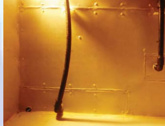
Türkiye de İlk Olarak PE Plakalardan İlimizde Depo Sızdırmazlığı Yapıldı.
