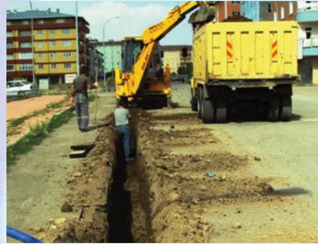
Şehir Merkezine 12.520 Metre Yeni İçmesuyu Hattı Yapıldı
