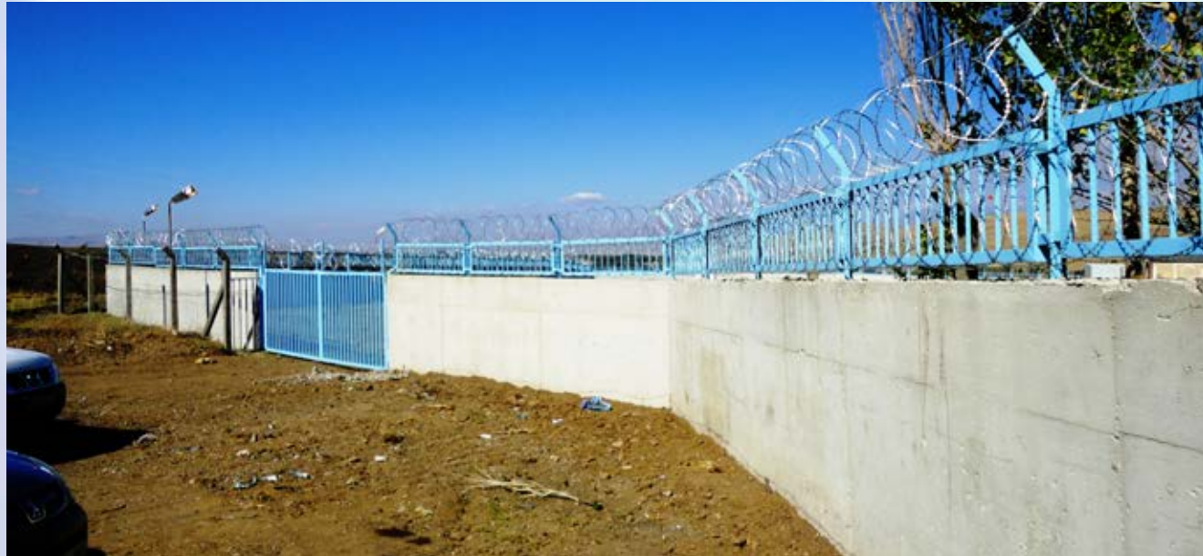
4000'lik Su Depo Çevresi Beton Perde ve Tel Örgü Yapımı
