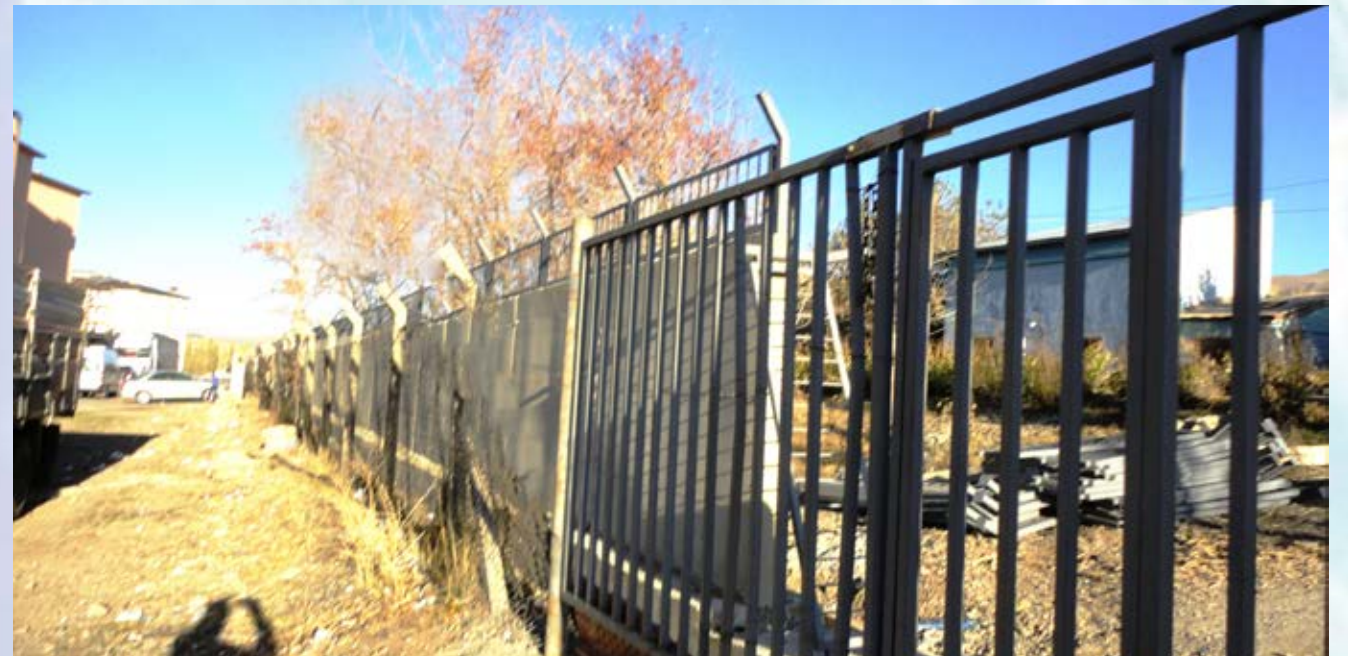
2 Adet Deponun Etrafı Betonarme Duvar ve Tel Örgü İle Çevrildi
