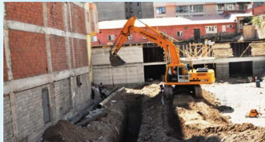
Su yolu çelik boru içine alındı
